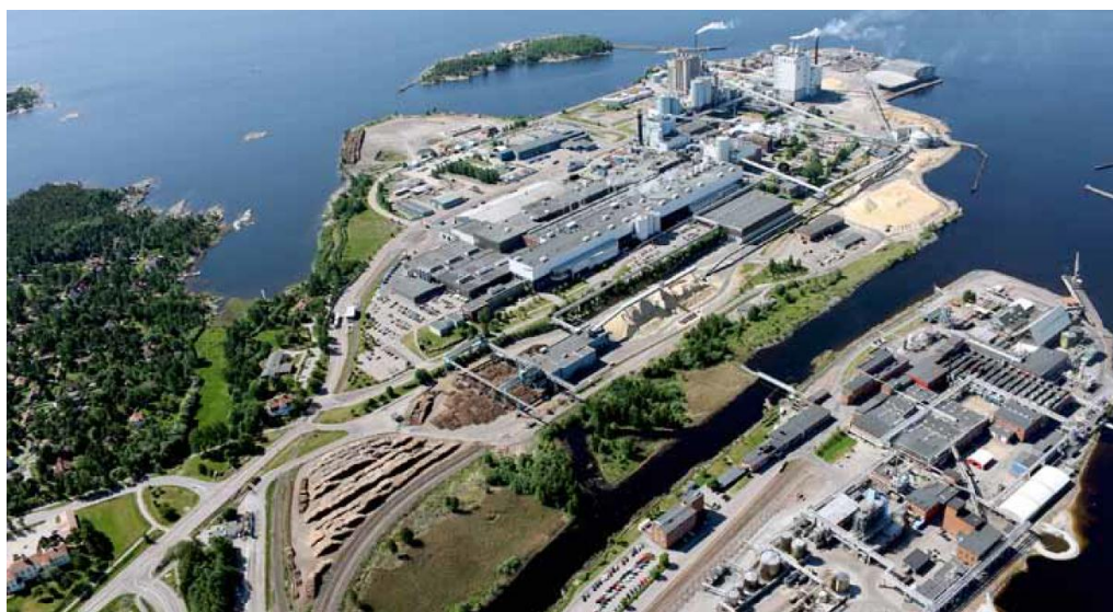
Bild 2. Översikt över Stora Enso Skoghalls bruk
